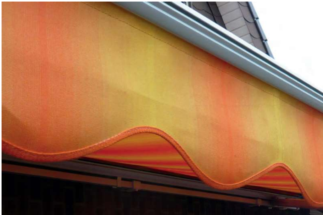
9.1.19 Zulässige verpackungsbedingte Faltenbildung im Volantbereich
